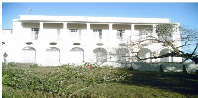
Vista lateral da Casa Grande de Oiteiro
